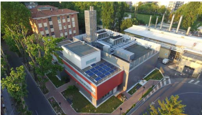
Veduta aerea della Centrale di Trigenerazione
