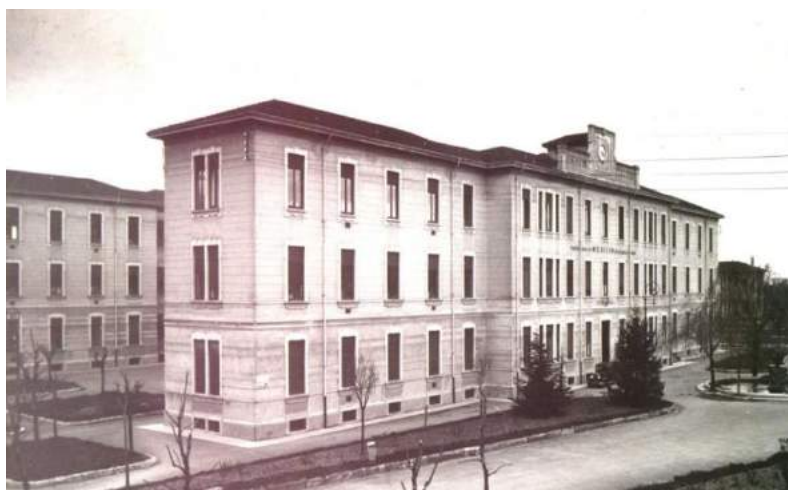
Il Padiglione Cattani prima dell'esplosione
