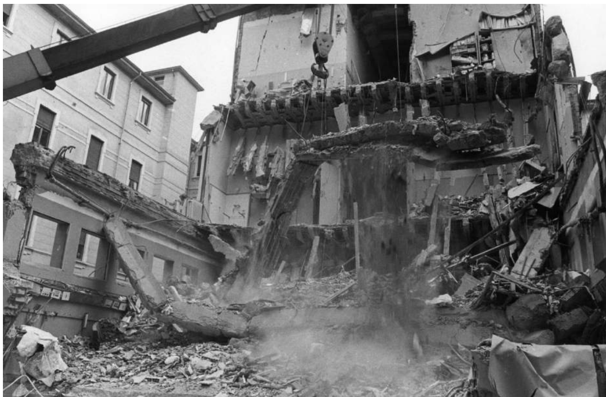
La gru in azione durante gli interventi di sgombero delle macerie
